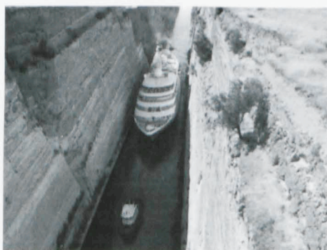
Rys. 3. Kanał Koryński mimo krótkiej długości ma na swej długości kilka mostów. Osobliwością techniczną są dwa mosty zwodzone o konstrukcji zanurzanej pod wodę
