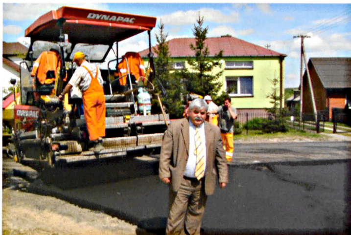
Budowa asfaltowej nawierzchni drogi w Czosnówce.
