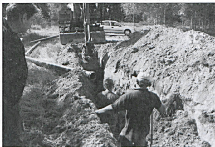
Dzięki funduszom unijnym na terenie gminy w ostatnich 4 latach wykonano 400 przyłączy wodociągowych
