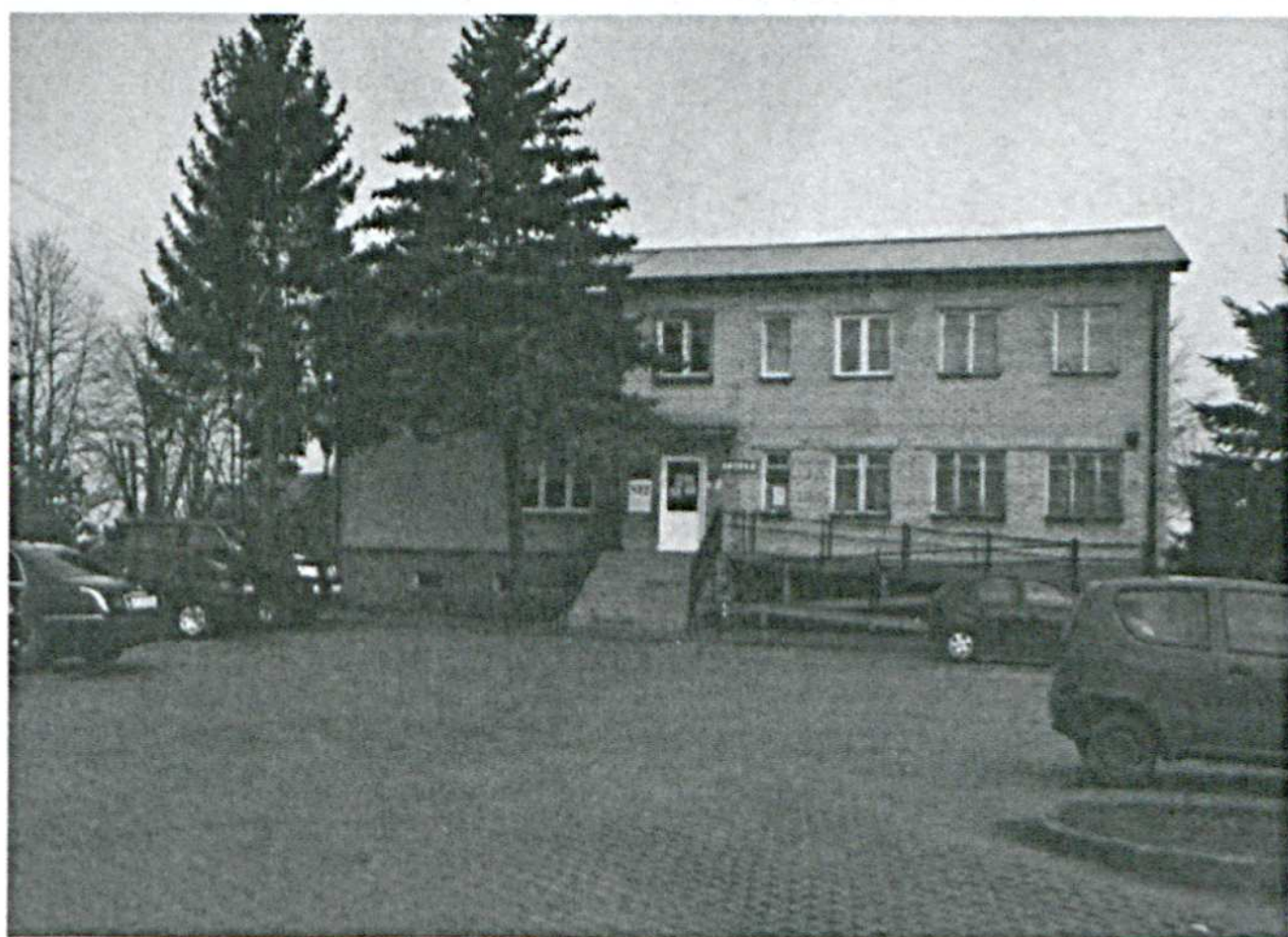
Wkrótce wygląd budynku Ośrodka Zdrowia w Drelowie znacznie się poprawi
