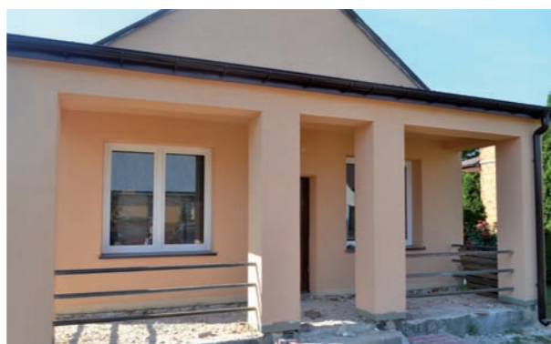
Prace remontowe w świetlicy w Krzymoszycach dobiegają końca.
