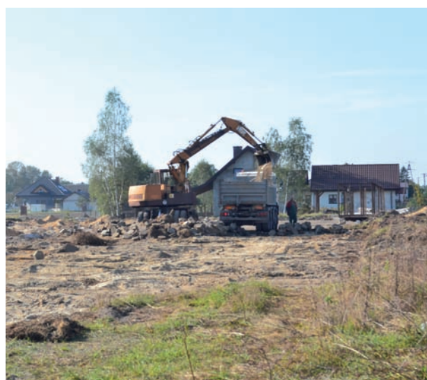
Oczyszczony teren po byłym SKR w Rzeczyicy
