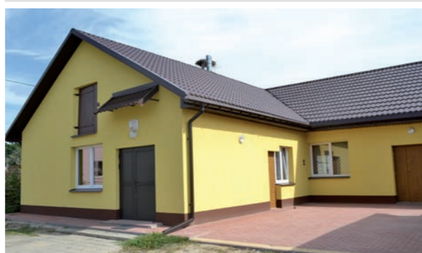
Wyremontowana i wyposażona w sprzęt świetlica w Łukowisku
