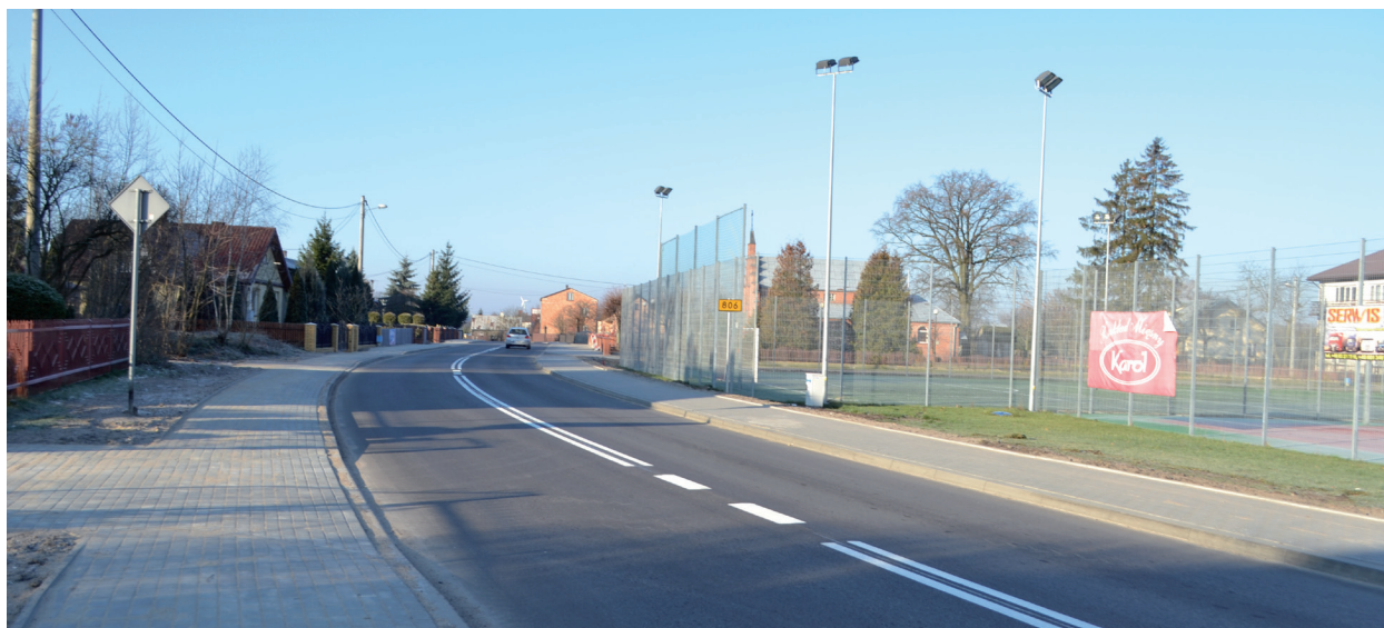
Fragment drogi wojewódzkiej nr 806 w Jelnicy w okolicach Publicznego Gimnazjum Nr 1 w Jelnicy. Widoczne są szerokie chodniki po obu stronach jezdni oraz nowa nawierzchnia asfaltowa.
