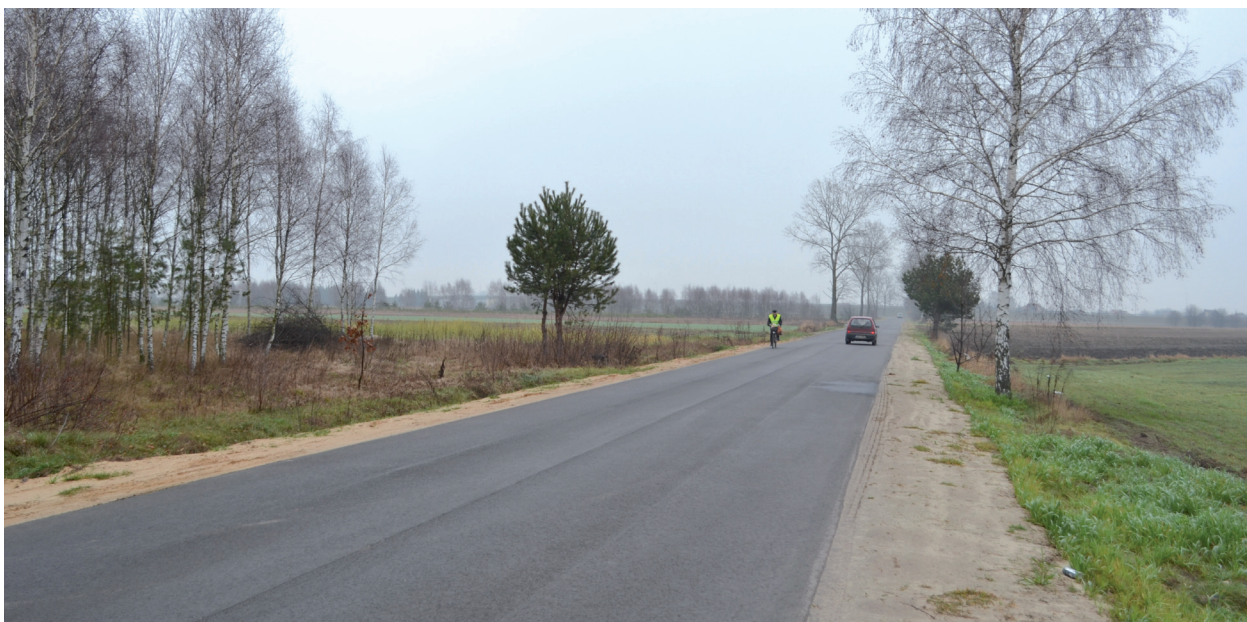
Nowa nawierzchnia drogi powiatowej biegnącej do Kol. Jelnicy
