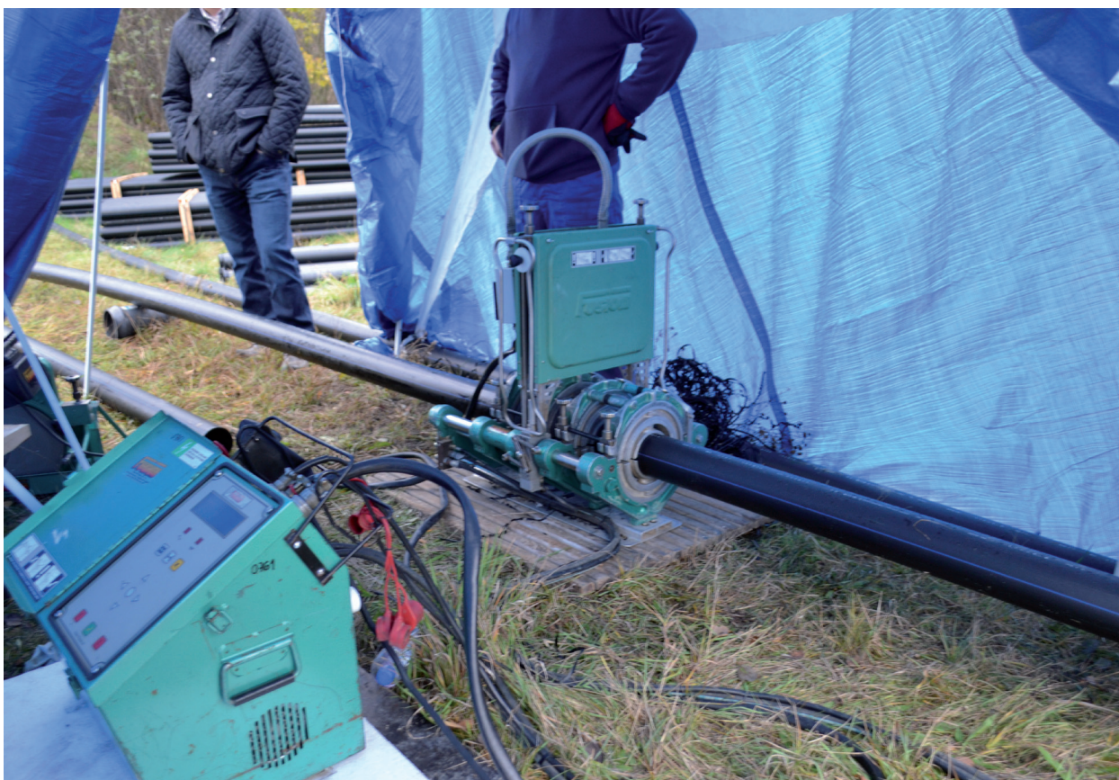
Na fotografii widoczne jest specjalne urządzenie do półautomatycznego zgrzewania doczołowego rur z polietylenu.
