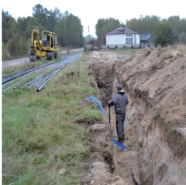
Prace ziemne podczas budowy wodociągu
