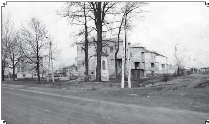
Osiedle przy ul. Młynarskiej
