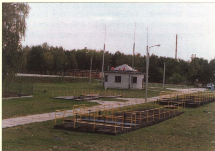
Zakładowa oczyszczalnia ścieków Water treatment plant
