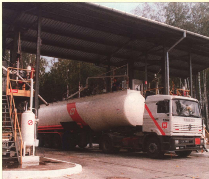
Każde z 6 stanowisk napełniania autocystem ma wydajność 1200 l/min. Each one of the truck cistern loading stands has working capacity of 1200 liter per minute.
