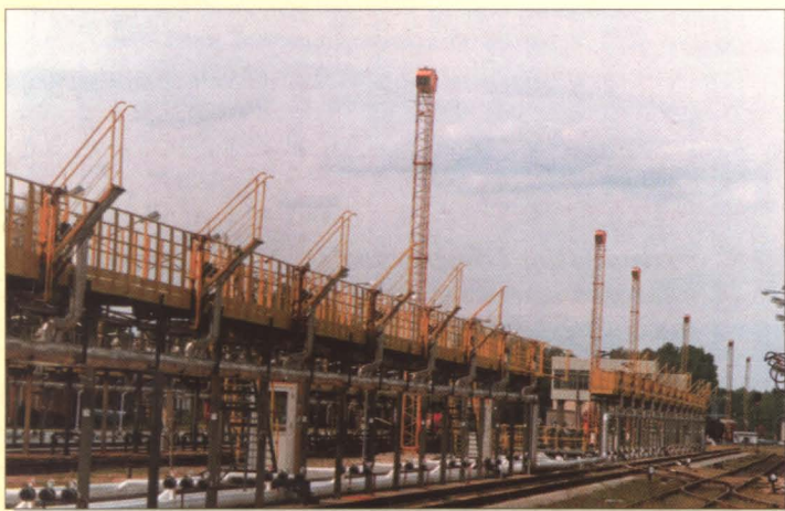
Nowe stanowiska przeładunku paliw z cystem wagonowych A new fuel reloading facility (of the cisterns)
