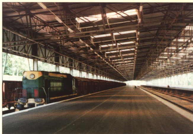
Najnowsza inwestycja DRP Małaszewicze - hala w terminalu Kowalewo umożliwiająca przeładunek „pod dachem” towarów w relacji wagon-wagon i wagon-TIR. The latest Małaszewicze DRP's investment - the reloading room in the Kowalewo terminal, it will enable reloading „under the roof” of trucks and railway cars.
