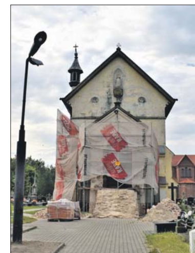
Kapitałny remont obejmie całość zabytkowego budynku
