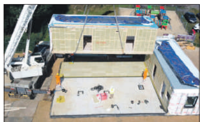
Modułowy komisariat w Piszczacu
