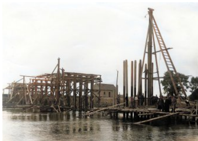
Budowa mostu na rzece Bug. Po prawej kafar. fot. Biblioteka Publiczna w Kodniu.
